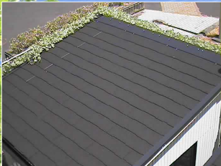
ミニハウス屋根の 表面温度（正午頃）
