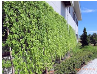
写真1 北部浄化センター
